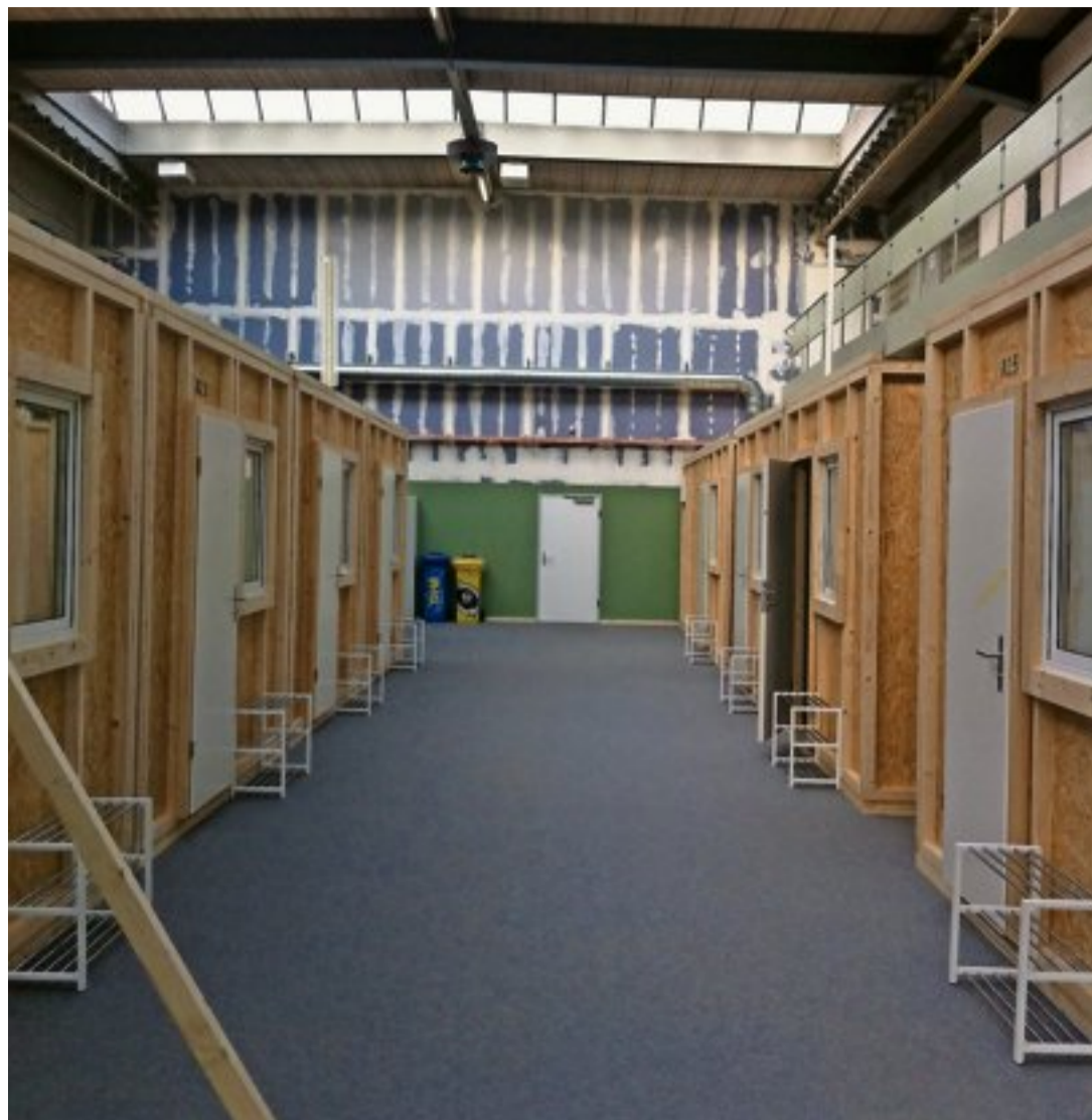
Spartanisch: Die Häuschen sind innen weiss gestrichen, die Gipstrennwand (hinten) ist nur unten verputzt. mgm
